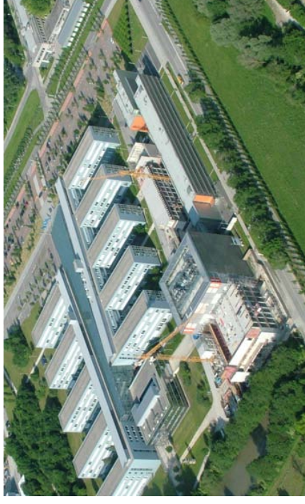
Abbildung 2: Der Bau für den SuperMUC, der die Heizleistung für die Therme zur Verfügung stellen wird, getarnt als wissenschaftlicher Supercomputer. 1-200.000 Prozessoren wird man brauchen, um angenehme Temperaturen bereitzustellen (sog. Heißwasser-Kühlung!)
