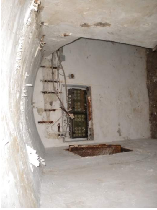
Erfüllung des Plansolls bei der Elektroinstallation
