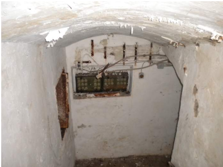
Erfüllung des Plansolls bei der Elektroinstallation
