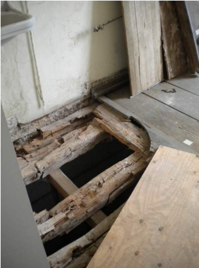
Erfüllung des Plansolls beim Bodenbelag
